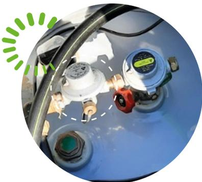
**Unterirdischer oder oberirdischer Tank mit Druckregler und Druckbegrenzer mit Messpunkt.**
